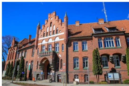
budynek Urzędu Miasta w Braniewie
