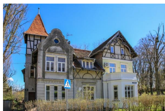
budynek mieszkalny przy ul. Botanicznej 5
