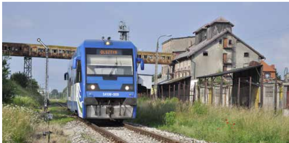
W latach 2022-2023 zaplanowano kontynuowanie przebudowy trasy z Ornety w kierunku Pieniężna. Fot. Łukasz Niegowski
