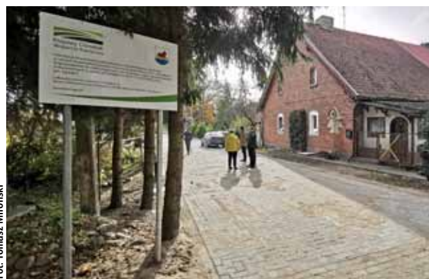
Otrzymana bezzwrotna pomoc umożliwiła wymianę wysłużonej już nawierzchni z lat 70. na nowoczesną kostkę brukową
