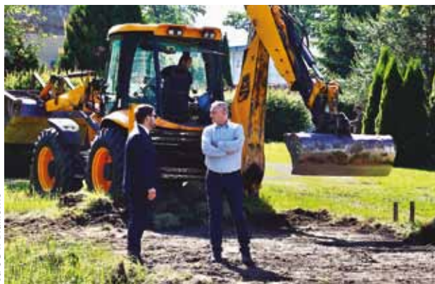
Pierwsze zaplanowane prace to przygotowanie terenu pod ławy fundamentowe i zalanie ich betonem
