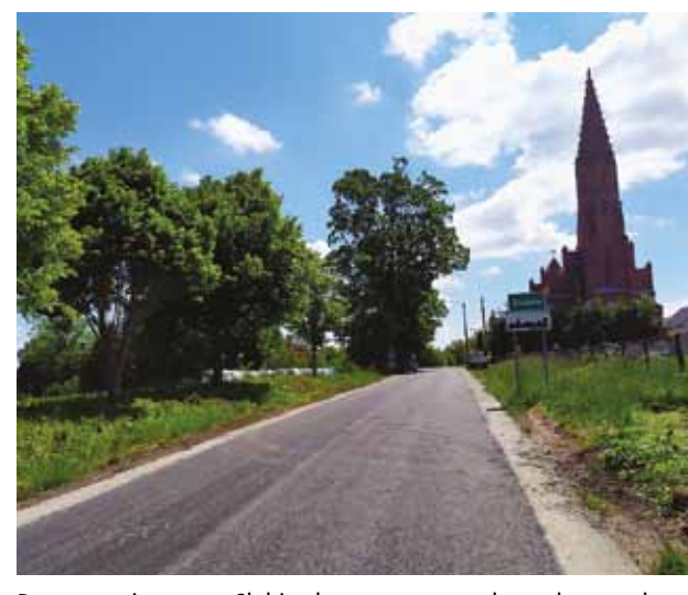
Droga powiatowa w Słobitach, po przeprowadzonych pracach remontowych
