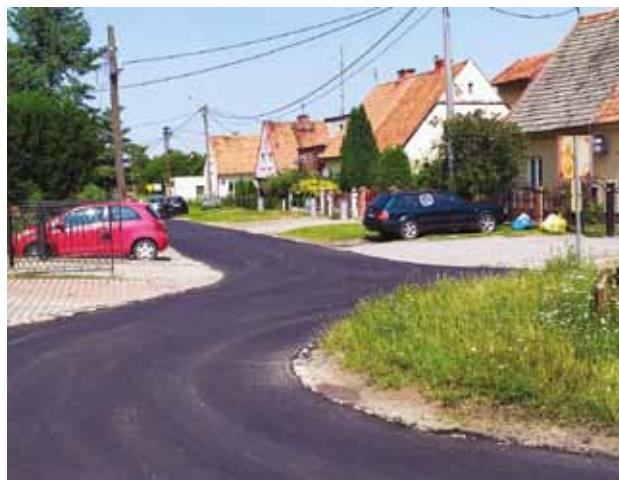
Braniewo, wyremontowany odcinek ulicy Długiej
