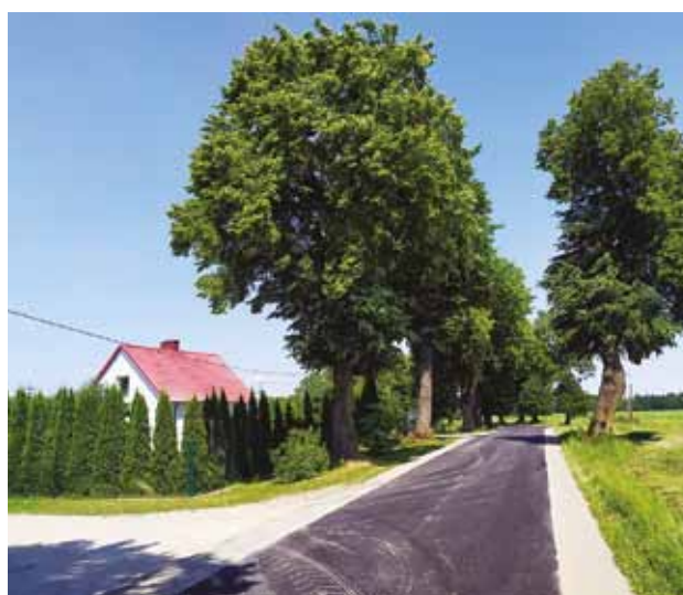
Nowa nawierzchnia na drodze powiatowej z Lutkowa do Jachowa
