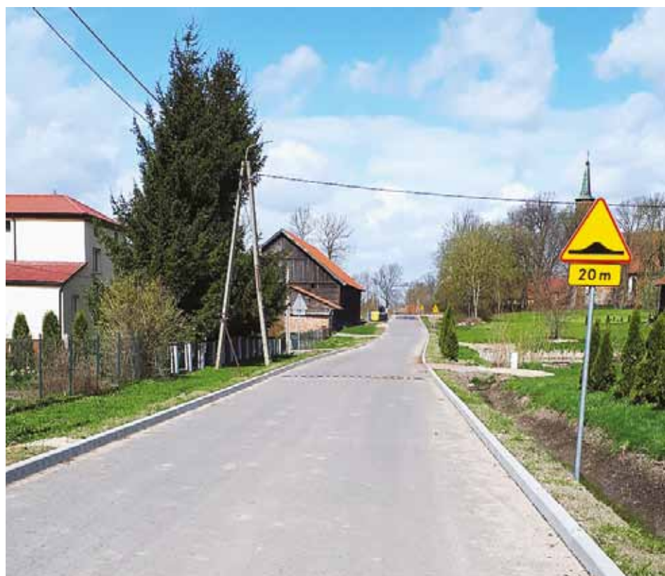
Wyremontowana droga w Windzie
