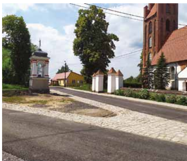
Wyremontowana droga w Tolkowcu
