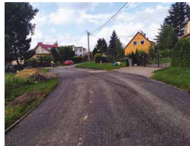
Nowy asfalt na ul. Jagiełły w Braniewie
