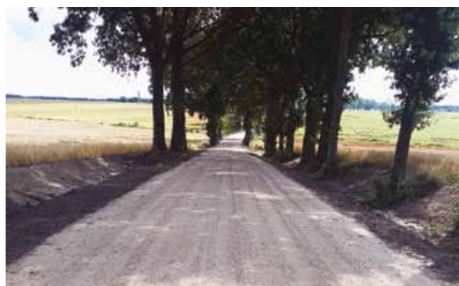
Zmodernizowana droga Skierki – Staniszewo
