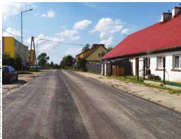
Nowa nawierzchnia drogi w Lipowinie
