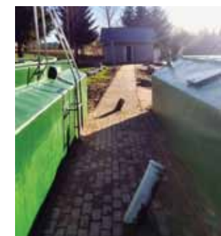
Oczyszczalnia w Zagajach przeszła gruntowną modernizację
