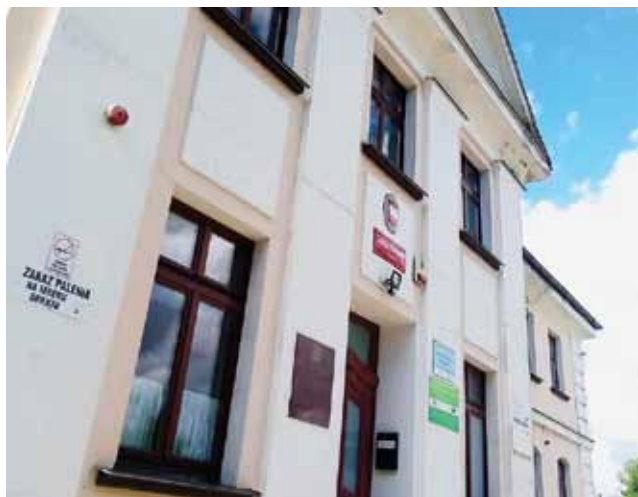
W 2024 roku wykonany zostanie remont elewacji w Szkole Podstawowej w Zagajach
