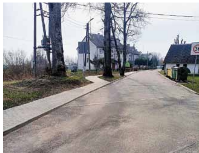
Droga gminna w Wyszkwowie
