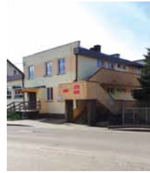
Budynek Gminnego Centrum Kultury w Lelkowie przeszedł szereg remontów wewnątrz, planowana jest również jego termomodernizacja
