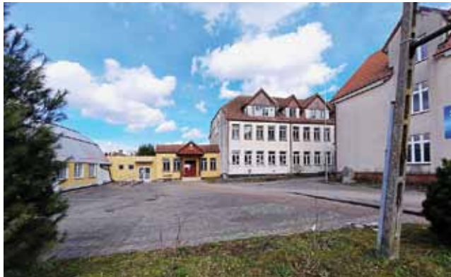
Szkoła Podstawowa w Lelkowie ma przejść kompleksową termomodernizację
